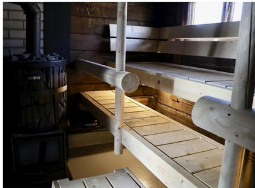
Jäälänmajan saunarakennus koki täydellisen remontin.
