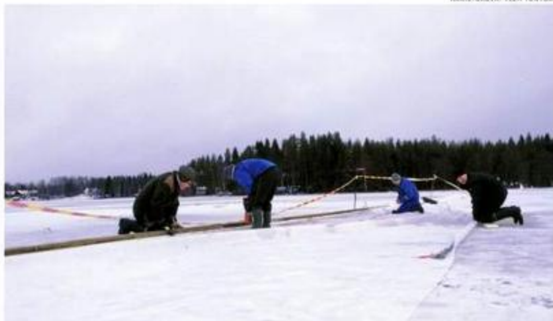
Jäälänjärven laskeutusallasta rakennettiin talvella 2020. Rautavirta-tutkimuksessa todettiin, että allas toimii parhaiten rautavirran torjumisessa jäälänjärveen.
