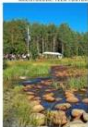
Kalamäessä vesistökunnostuksen työ on kulkijoiden näkyvillä.
