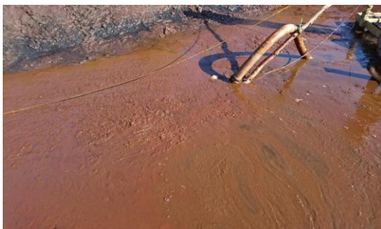
Kiimingin – Jäälän vesienhoitoyhdistys poistaa rautalietettä pumppaamalla Kokkoäärän ja Kalamäen lietteenkeruualtaista. Vuotuinen määrä on 5-8 tonnia kuiva-ainetta. Suurin osa rauta-humus kiintoaineesta läpäisee lietteenpoistojärjestelmät ja päätyy Jäälänjärveen.
