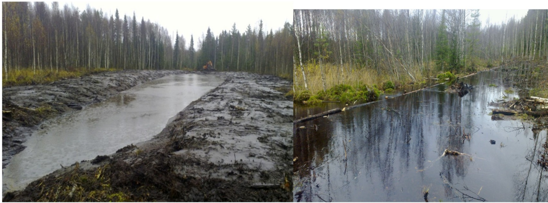
Kuva 7. Saarisenojan valuma-alueelle syksyllä 2012 tehtyjä vesienhoitorakenteita. Vasemmalla Saarisenojanniityn pintavalutuskentän yläpuolinen laskeutusallas. Oikealla Kokko-ojan haaran suistepatoja, kun vesi on noussut alueen tulvavyhyille.
