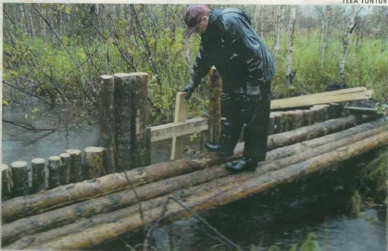
Eero Laine esittelee neulapadon toimintaa Kokko-ojan haara-alueella. Pato nostaa veden suolle, jonka läpi vesi kulkeutuu takaisin ojaan....
