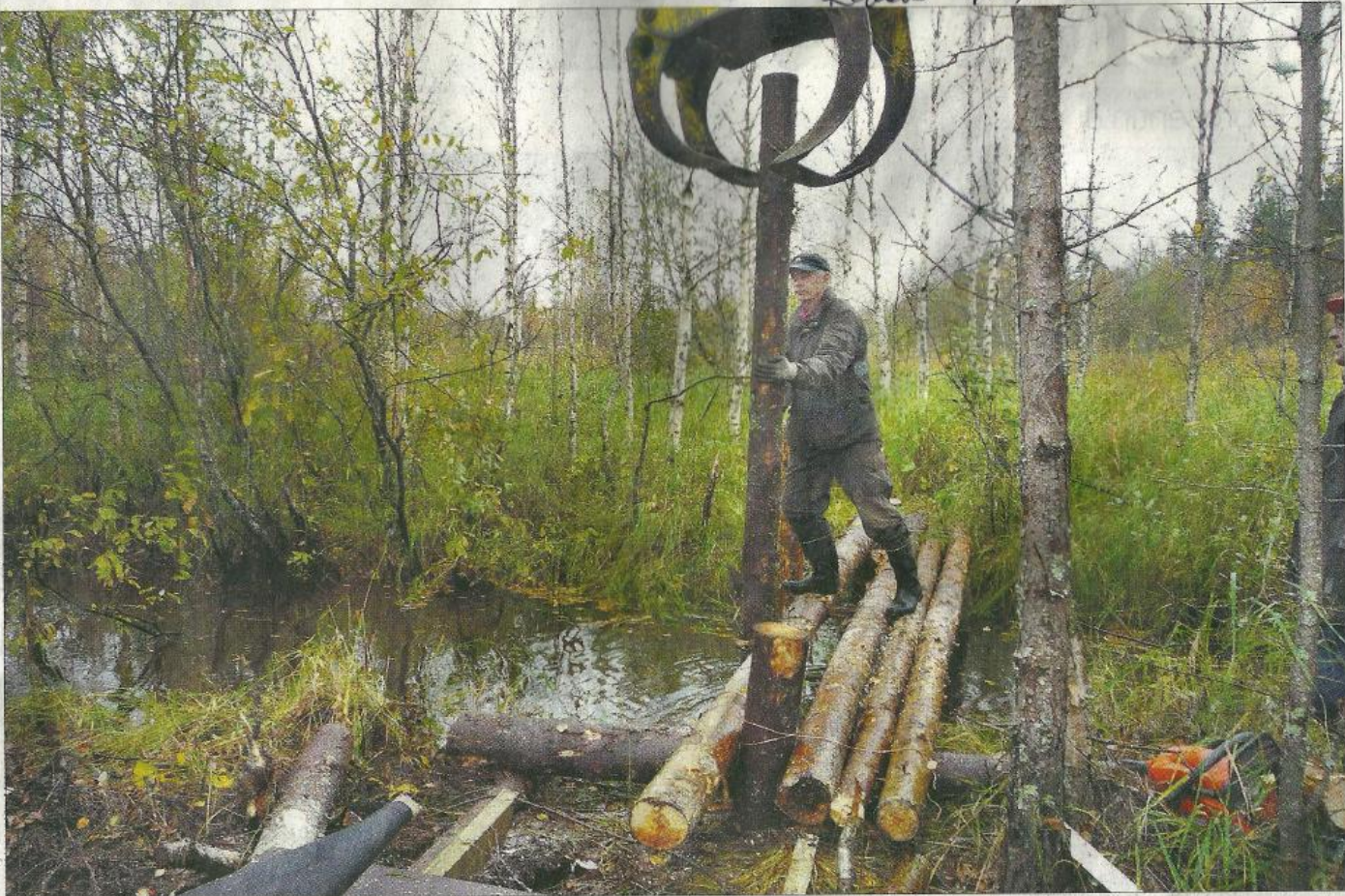
Jäälinjärven yläpuoliseen Saarisenojan rakennettiin säätö- eli sulkupato, jonka tarkoitus on nostaa vettä ojan reunamille padon yläpuolella. Birger Ylisaukko-oja talkoilee Saarisenojan padon rakentamisen alkuvaiheessa.
